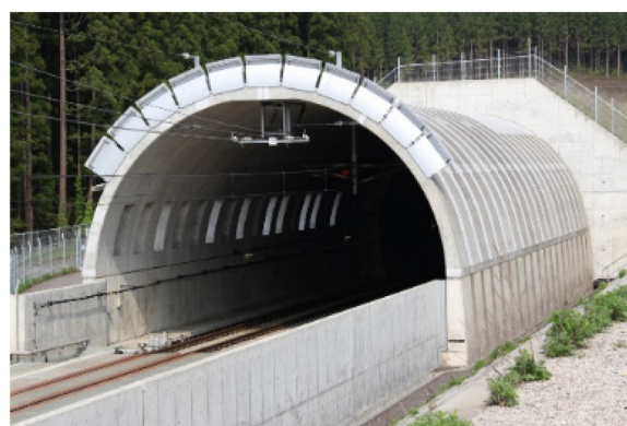
図1 新幹線に設置されている緩衝工
