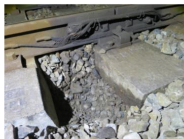
図1 保守頻度が少ない地点のバラストの状態(地点5) 5)
