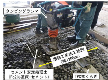
図7 増強工の構築状況 (幅1200mm)
