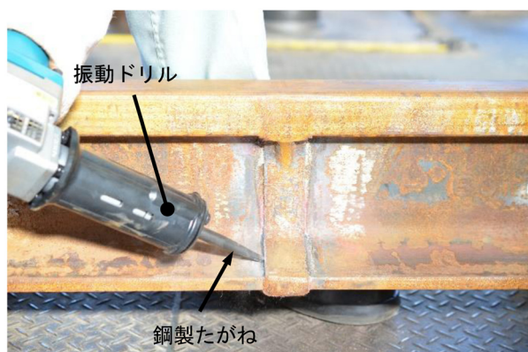
図3 余盛止端部へのピーニング処理
