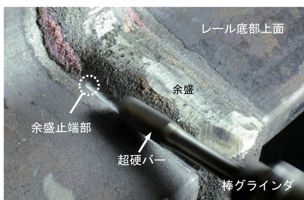
図11 余盛止端部の研磨処理
