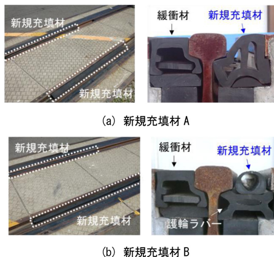
図3 各新規充填材の設置状況および断面の写真
