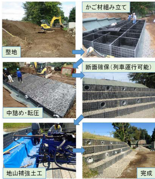
図8 提案構造の施工手順
