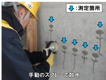
(a) 測定状況(水の流下後)
