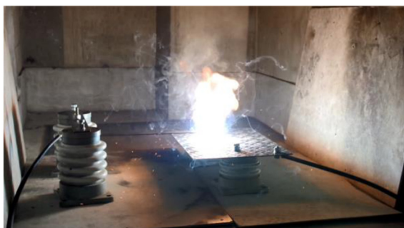
図 13 人工模擬故障試験状況（Y線 A 変電所）
