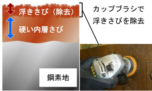
(a) さび層と浮きさびの除去
