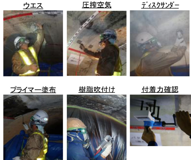
図 11 施工状況写真
