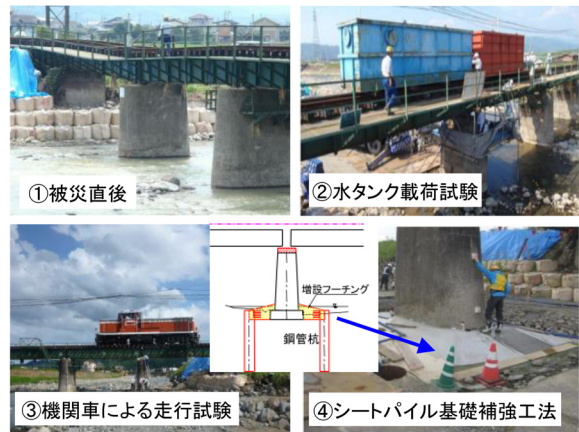
図 6 隈上川橋梁（JR 九州久大線）
