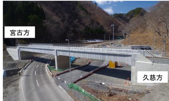
図4 ハイペ沢橋梁(三陸鉄道北リアス線)
