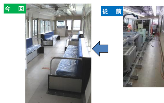
(d) 客室内の状況
