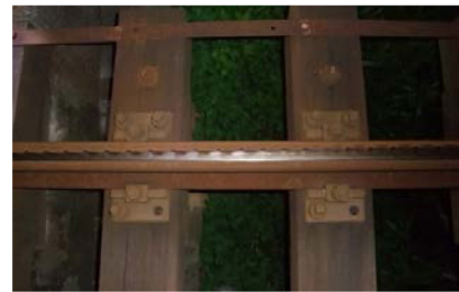
図9 波状摩耗の外観 (営業線 B) (①軸距間でのレール波動の干渉によるその他の例)
