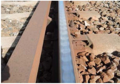
図 10 波状摩耗の外観（営業線 C） (②軌道弾性支床の反共振現象による例)
