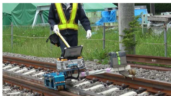
図4 レール凹凸連続測定装置による測定状況
