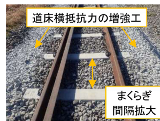
図3 低コストロングレール軌道構造の施工例
