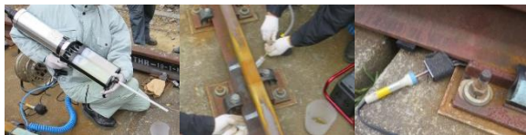
(a) 二液先端混合装置 (b) 注入状況 (c) 注入口の加温状況
