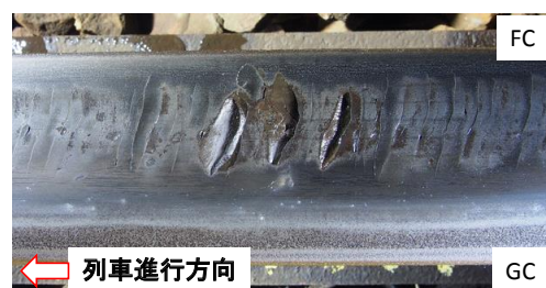
図1 中きしみ割れの外観
