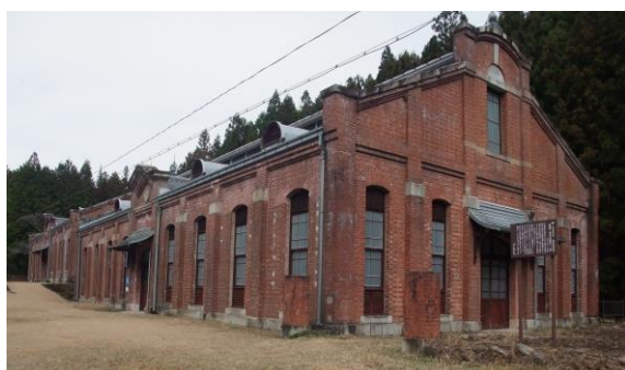
図2 丸山変電所・蓄電装置の復元した建物の外観
