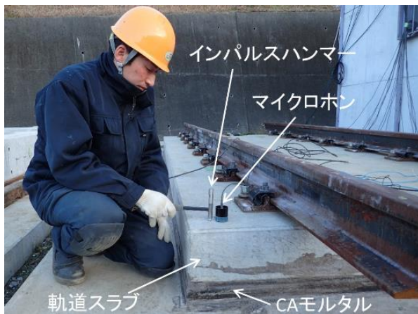
図7 打音試験の状況 3)
