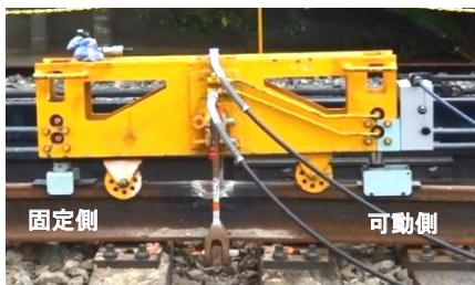
(b) 試作機による矯正状況
