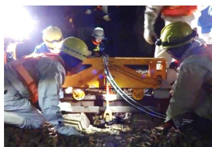
図11 現場施工試験状況
