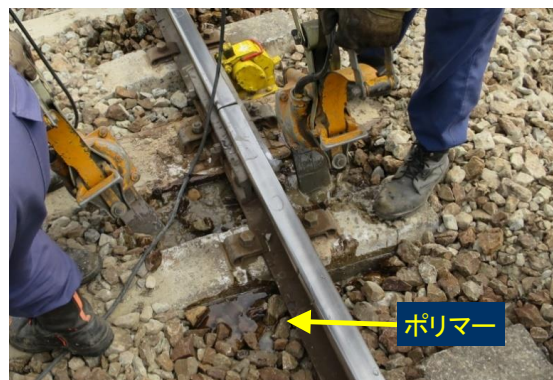
図1 ポリマー安定処理工法の実施状況
