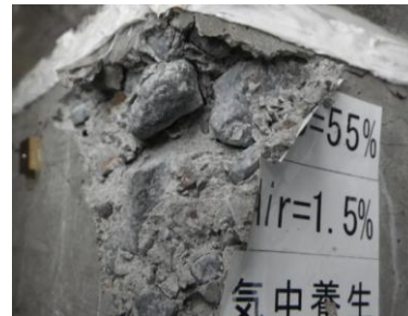
(2) 空気量 1.5%隅角部 (W/C=55%, 気中養生)
