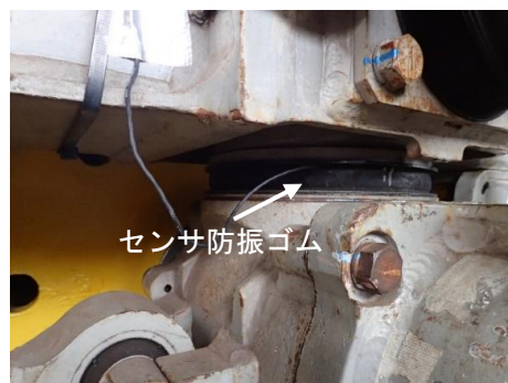
図13 センサ防振ゴムの設置状況
