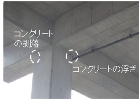
図 4-29 現地の状況（鉄道総研撮影）
