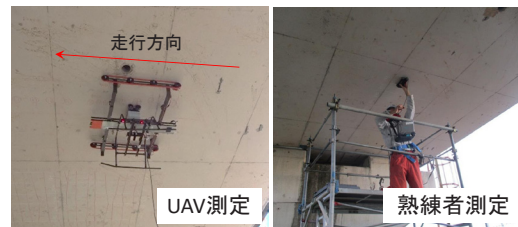
図 13 かぶり厚さの測定状況
