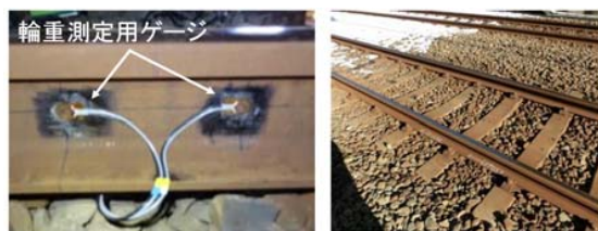
(a) 輪重測定用ゲージ (b) 測定線区
