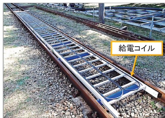
図5 給電コイルの敷設状況
