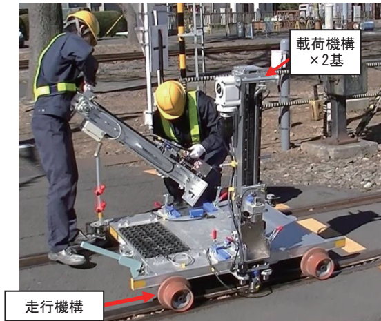
図17 RFWDの組み立て状況
