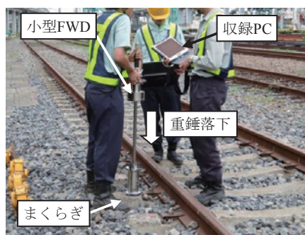
図1 軌道支持剛性の測定状況の例
