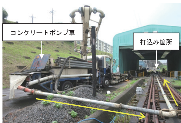
図 12 ポンプ圧送の状況
