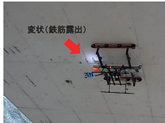
(a) 変状箇所の撮影状況
