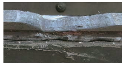
(a) 営業線で生じた段付摩耗すり板
