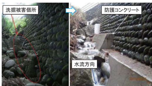
図8 ケース A23, A24 実施個所の状況 1)
