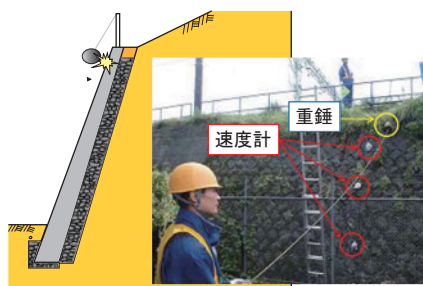
図3 土留め擁壁における衝撃振動試験 1)
