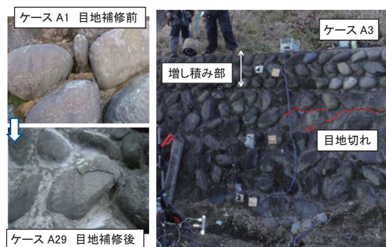
図4 ケース A1, A3 および A29 実施個所の状況 1)
