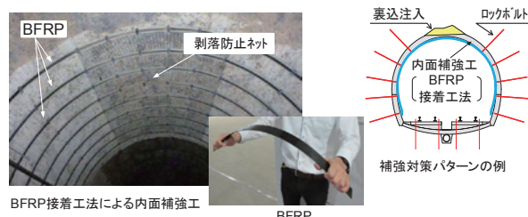
図7 山岳トンネル覆工の補強工法
