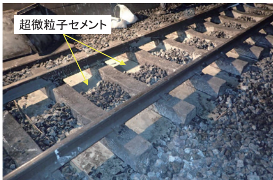
図13 試験施工の状況
