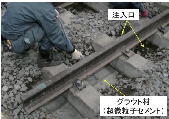
図7 グラウト材の注入状況
