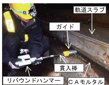
図2 衝撃貫入試験状況
