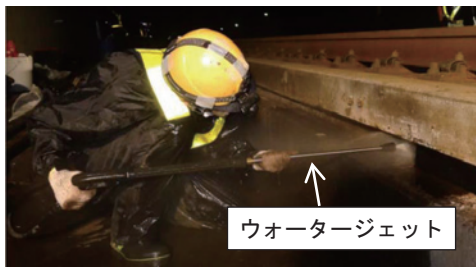
図 15 劣化 CA モルタル除去の状況
