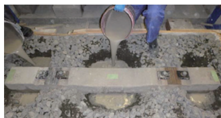
図8 超微粒子セメントグラウトの充てん状況
