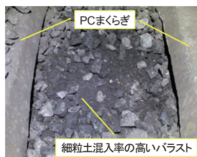
図6 トンネル区間の道床状態
