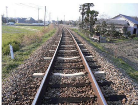
図 10 木まくらぎ軌道の部分 PC まくらぎ化
