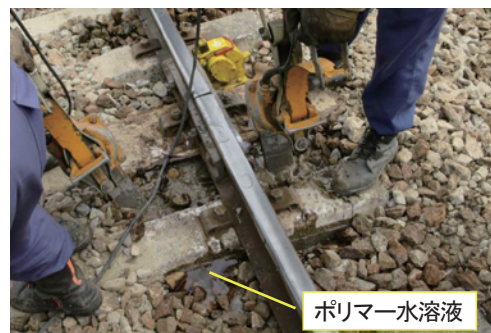
図4 ポリマー水溶液の投入
