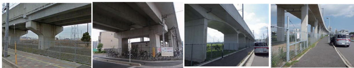
(a) 単柱橋脚（桁式） (b) 門型橋脚（桁式） (c) 壁式ラーメン (d) 柱式ラーメン
