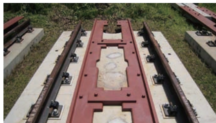
図5 逸脱防止装置の例 10)
