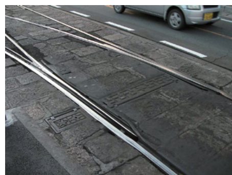
(b) 発条転てつ機 (大同キャストイングス製)
