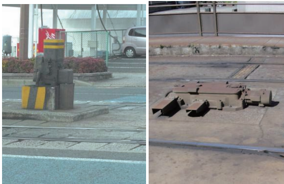
図2 動力転てつ機の設置例 (安全地帯, 停留場)
