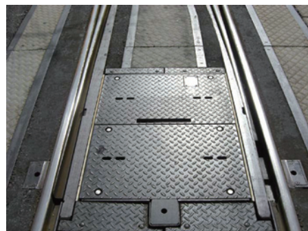
(a) 電気転てつ機 (VAE製)
