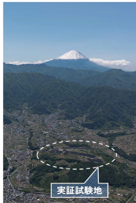
図3 米倉山太陽光発電所
