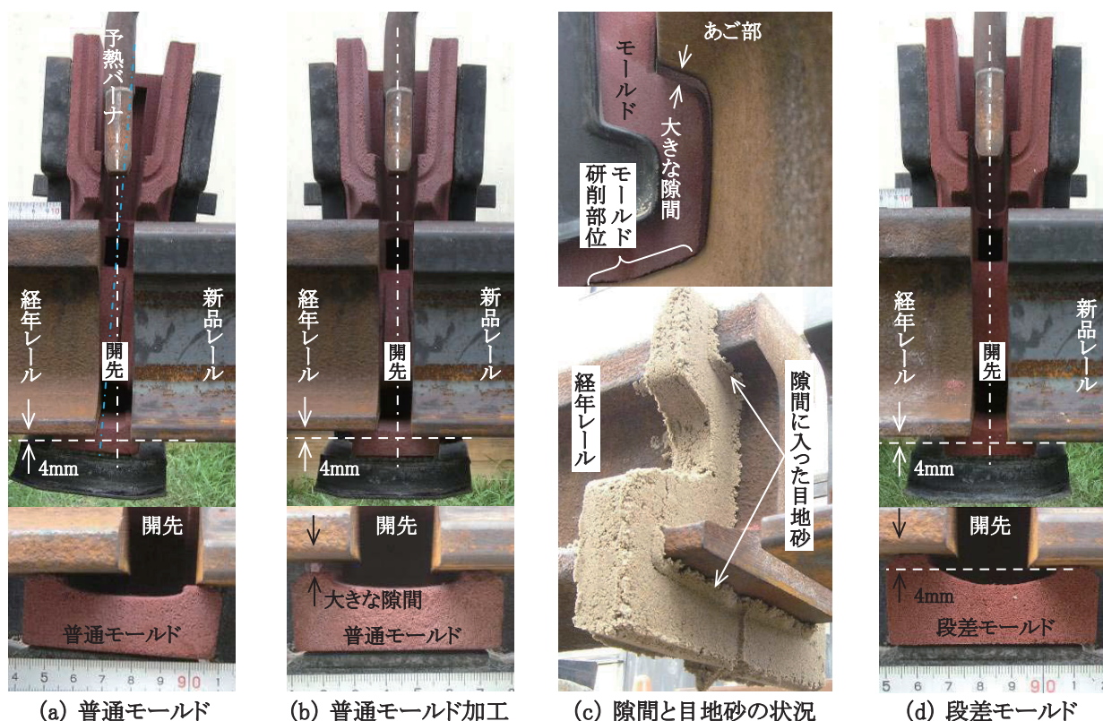
図3 段差レール溶接施工時におけるモールドの組み立て状態と隙間の状況
