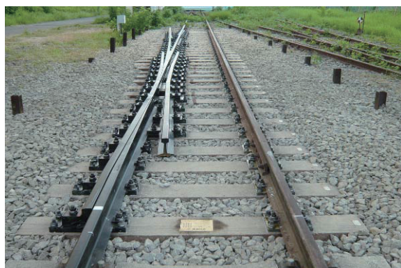
図 11 試験敷設状況
