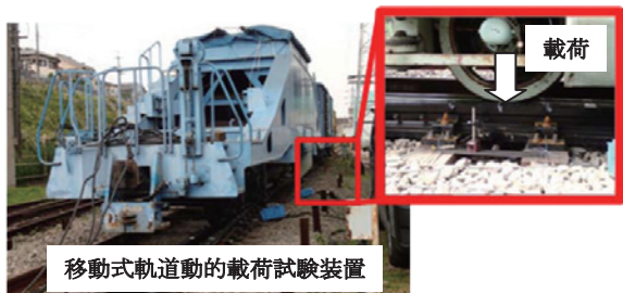
図15 鉛直载荷試験の状況
