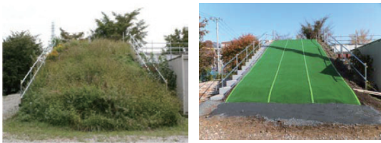
図16 のり面防護シート敷設前後の状況
