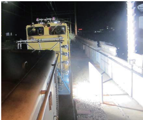
図8 高欄撮影の様子
