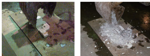
図 2 重機による破碎状況
