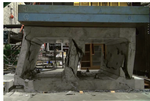
(b) 損傷状況(相対変位:約150mm)
