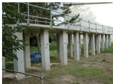
図3 RC高架橋試験体 10) の外観
