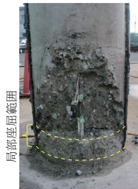
図6 荷重後の試験体内部の状況 (M-1)
