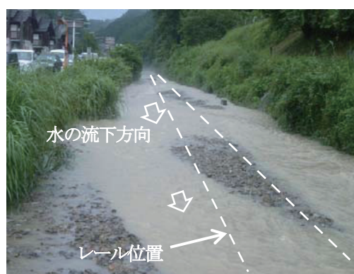
図4 両切土区間を流下する雨水（被災直後）
