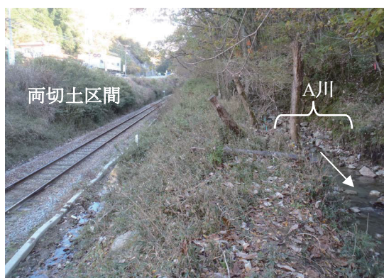
図3 両切土区間とA川の概況（終点方より望む）
