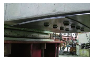
図13 アンカーによる鋼板取付
