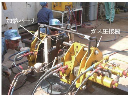
図 4 レールガス圧接試験体の作製状況
